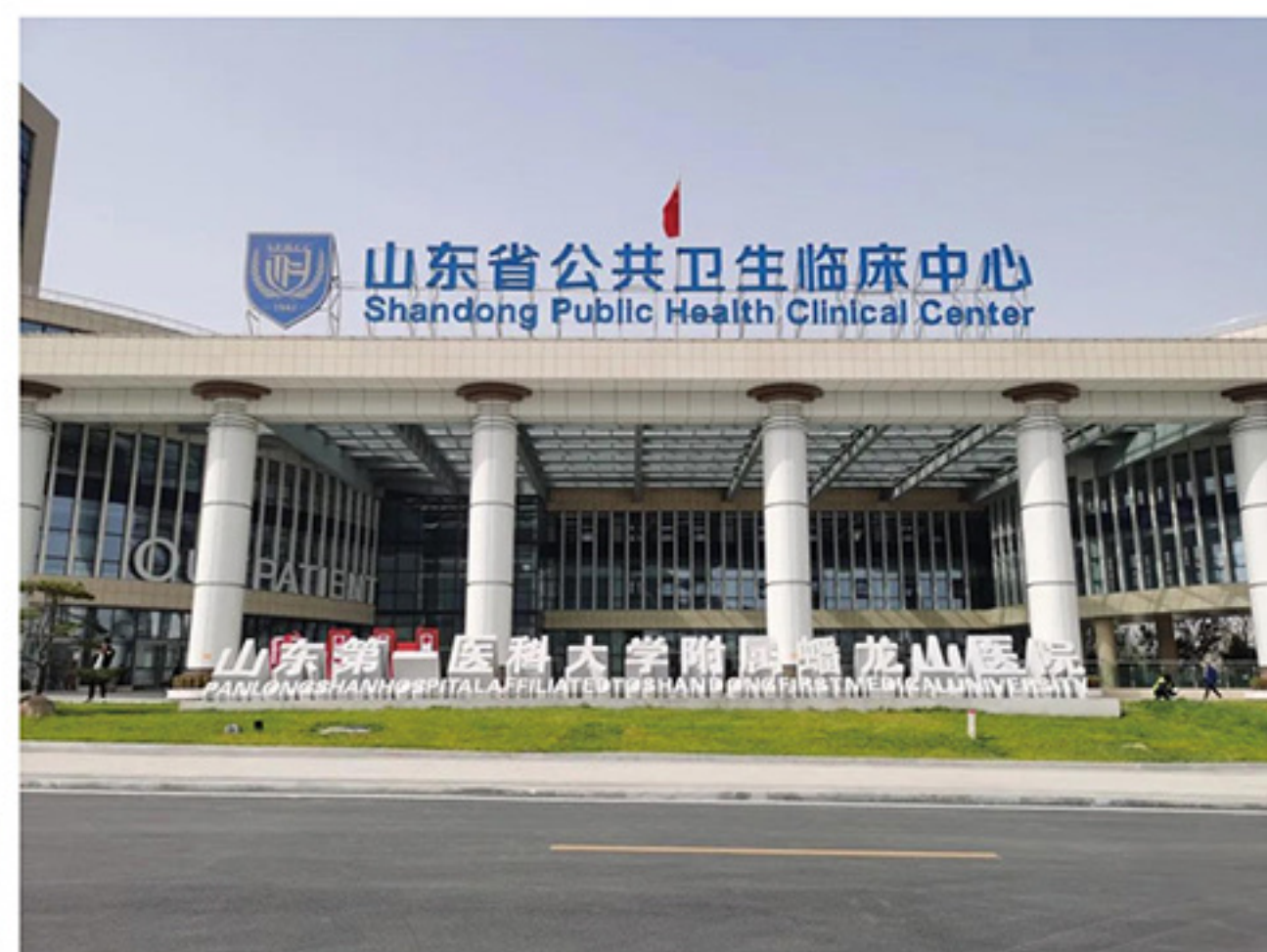
济南市传染病医院新建项目门诊医技住院楼
